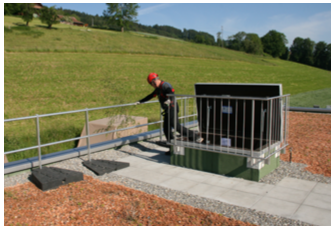
Fig. 36: Fenêtre d'accès au toit sécurisée par une protection latérale hors la zone de danger avec risque de chutes élevé. Avec une planification optimale, la fenêtre d'accès au toit conduirait au centre de la zone de danger
