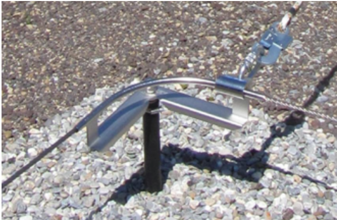
Fig. 17: Passage d'angle librement surpassable selon les indications du fabricant
