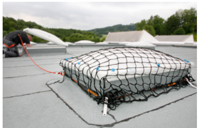
Fig. 39: Sécurisation temporaire d'une coupole de toit
