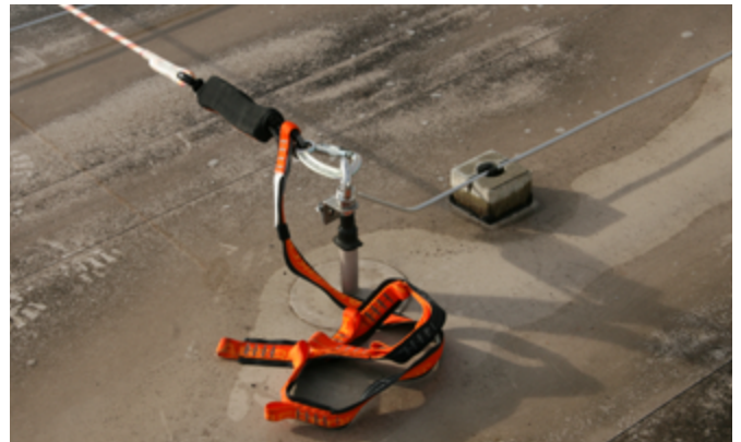
Fig. 12: Amortisseur de chute monté dans un système temporaire à corde (ligne de vie) pour limiter les forces sur les points d'ancrage
