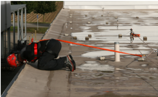
Fig. 9: Travail avec un système de retenue à un système temporaire à corde
