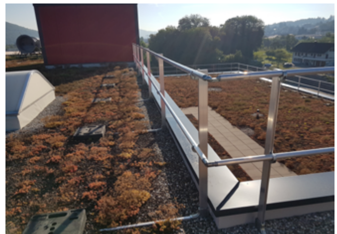
Fig. 23 Classe d'équipement 3: système de protection latérale avec poids de retenue
